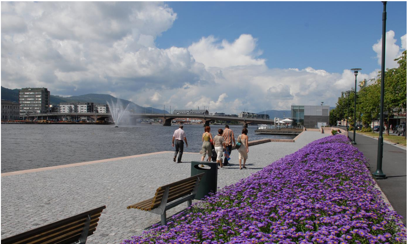
Bild ovan: Gångbron Ypsilon i Drammen som kopplar samman kunskapsparken och byparken Bild nedan: Älvpromenaden i Drammen
