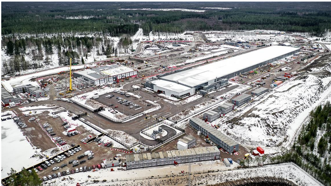
Figur 14 Microsofts anläggning i Sandviken under byggtiden
